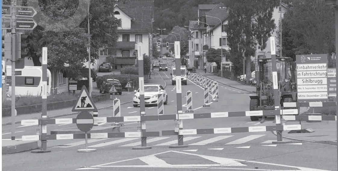
Baustelle Sihltalstrasse (Stand Oktober)
