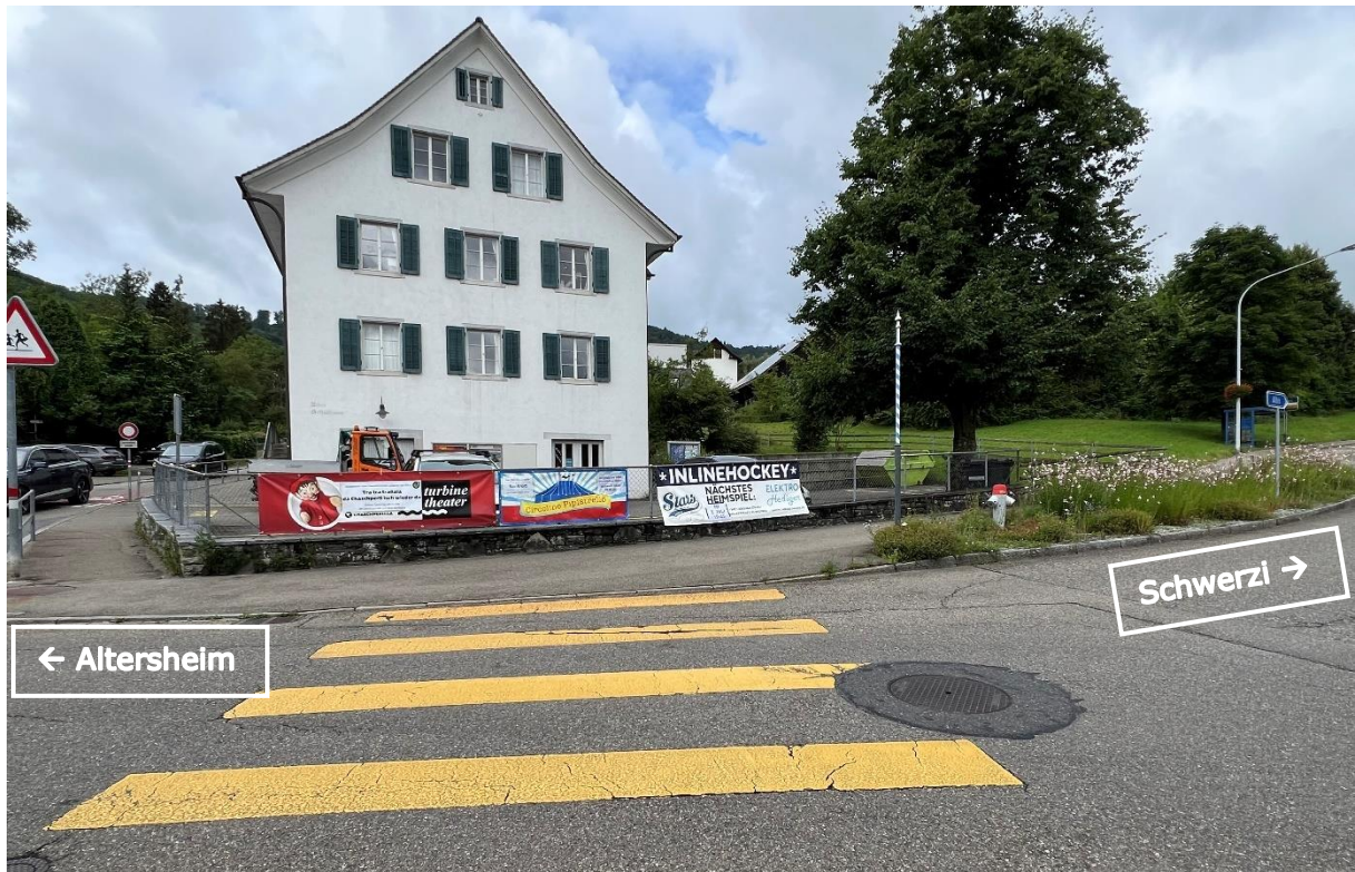
Altes Schulhaus Wolfgraben (Wolfgrabenstrasse 1), am Zaun
