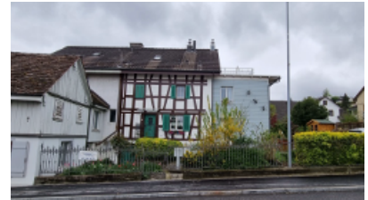
Neue Dorfstrasse 29 mit Anbau
