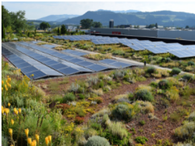
Kombination von Dachbegrünung und Solaranlagen
