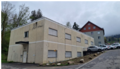
Gewerbebau Mühleweg 15, dahinter Neue Dorfstrasse 39/41
