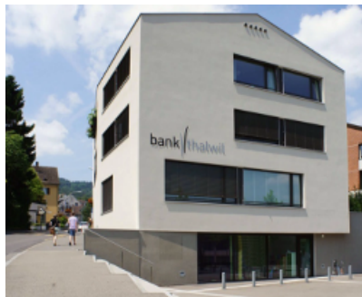
Ersatzneubau Neue Dorfstrasse 20
