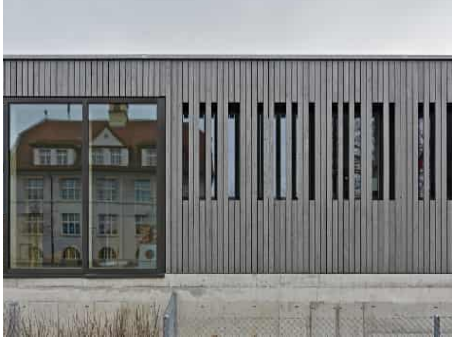
Fassade vor WC Fenster
