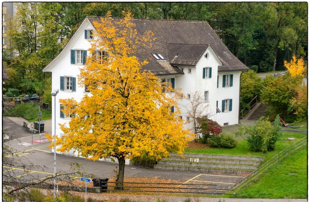
(altes Schulhaus Wolfgraben) Bild Markus Maurer
